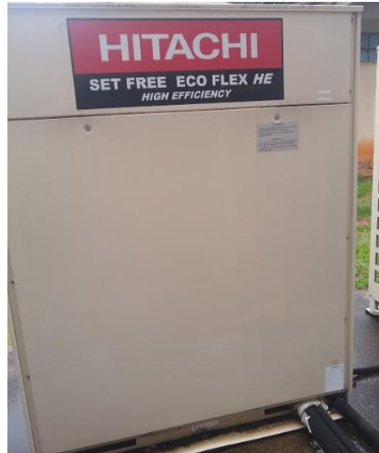
(b) Condensadora HITACHI modelo RAS12FSNH7B
