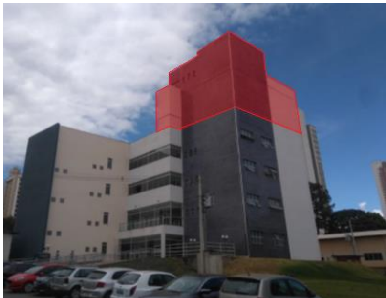
Figura 22: Volume da edificação entre a laje técnica e a laje de cobertura.
