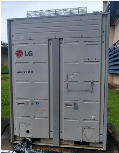
(a) Condensadora LG modelo BRUV160LTS4
