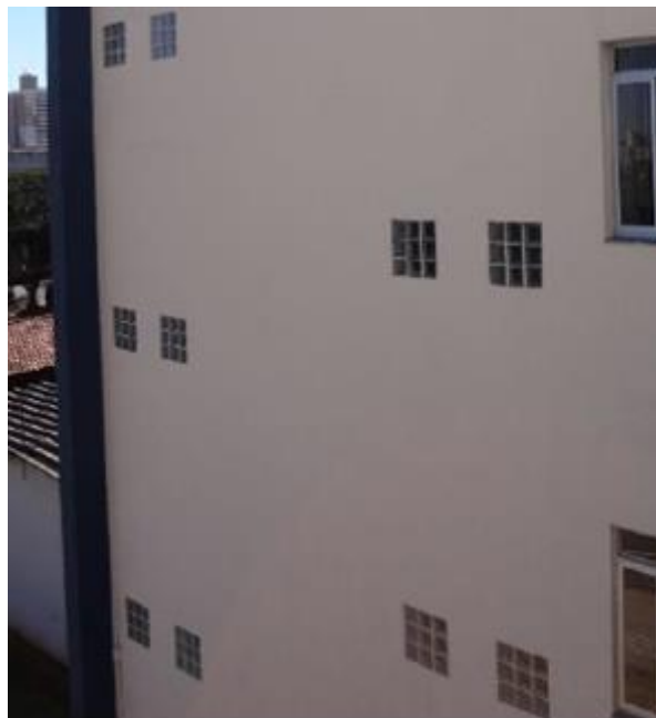
Figura 26: Aberturas em tijolos de vidro na fachada Oeste.
